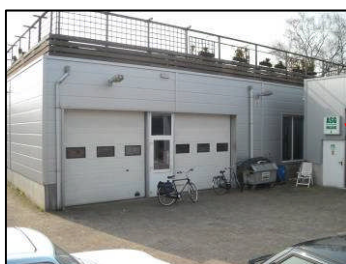
Dakterras op verdieping
