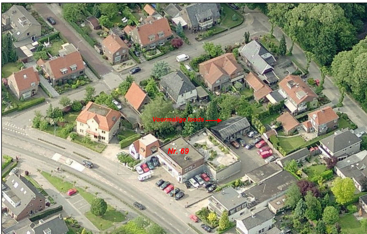
Luchtfoto Google Oude Kleefsebaan nr. 69 met de voormalige loods
