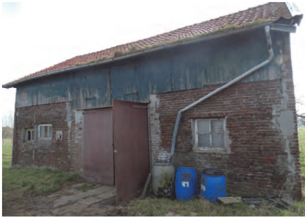
Figuur 3: De te slopen schuur
