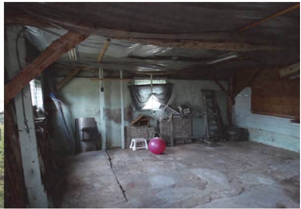
Figuur 4: Binnenzijde de te slopen schuur
