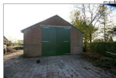
bestaande loods op bouwperceel
