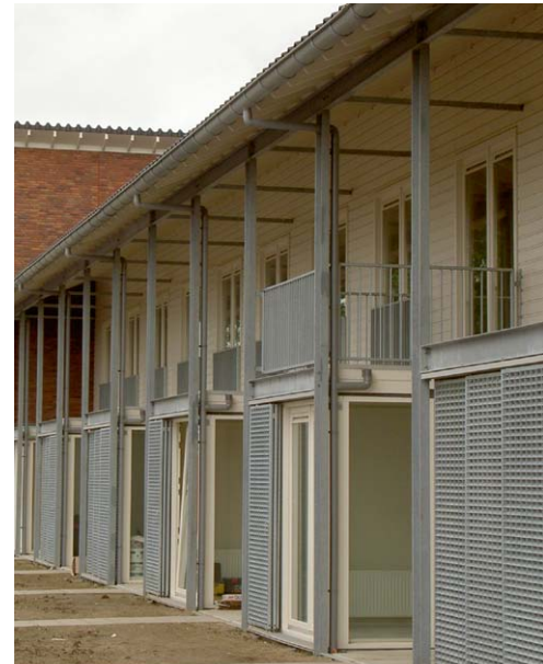
plasticiteit in gevel
