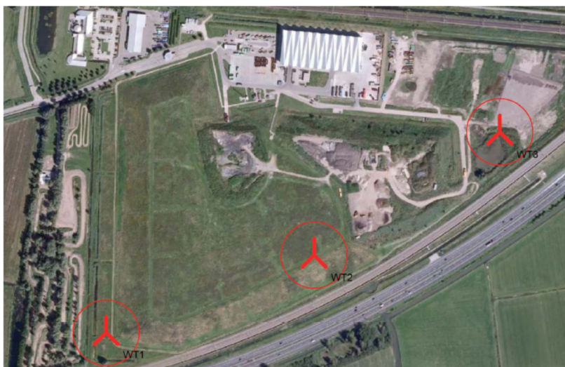
Figuur 1: Vervallen opstelling windturbines Windpark AVRI Geldermalsen
