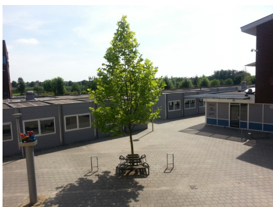
Bestaande noodlokalen ten zuiden van hoofdgebouw
