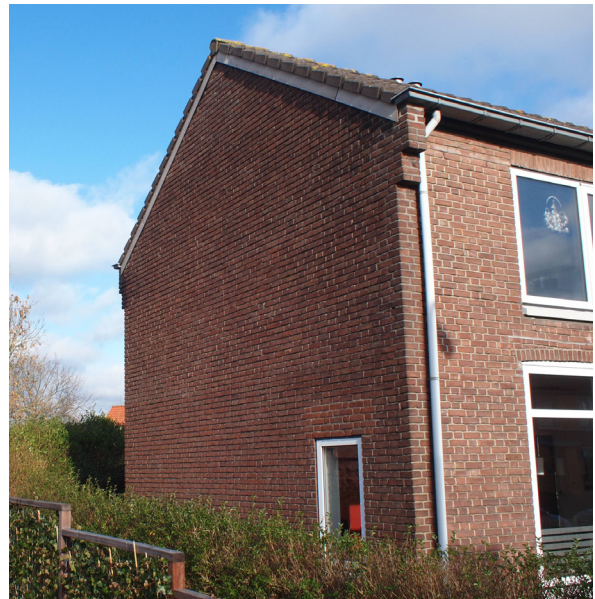
Afb. 2 Gevel eindwoning Badweg. Achter de gevelbetimmering is ruimte voor vleermuizen.
