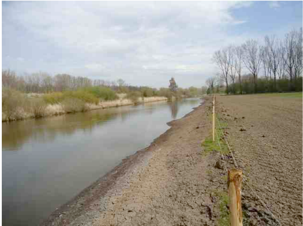
Foto referentie recent (voorjaar 2013) aangelegde natuurvriendelijke oever langs de Nieuwe Graaf net ten oosten van Leerdam.
