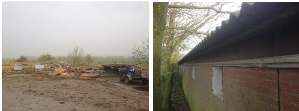
Figuur 3 Het plangebied heeft een rommelig karakter wat goede omstandigheden biedt voor kleine grondgebonden zoogdieren zoals muizen, egel en bunzing (links). De schuren zijn opgetrokken uit enkelsteens muren en een golfplaten dak wat ongunstig is voor vleermuizen (rechts).
