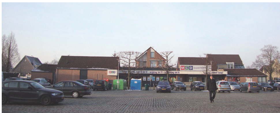
Huidige bebouwing MCD Supermarkt
