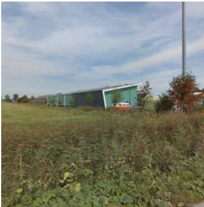
Nieuwbouw aan westzijde bedrijfsperceel
