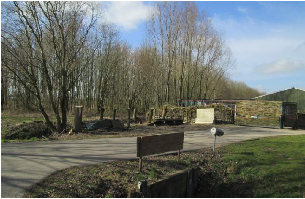
Voorzijde erf ter plaatse van de werktuigenberging.
