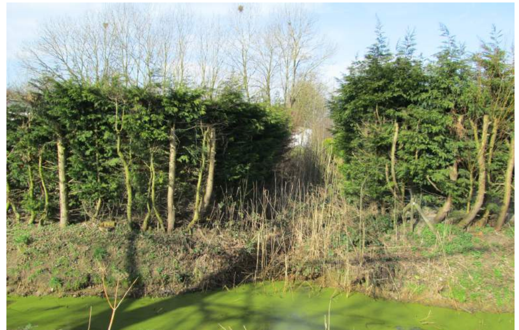
Bestaande sloot herprofiëren
