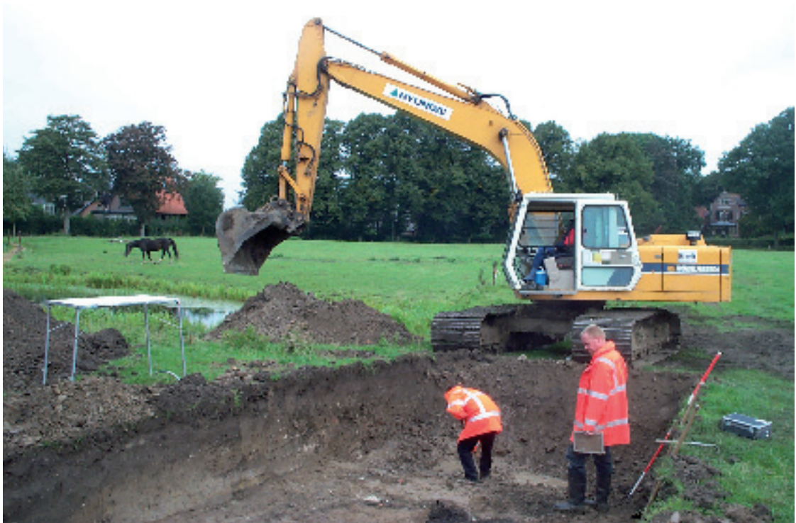
Afb. 5 De aanleg van werkput 3.
