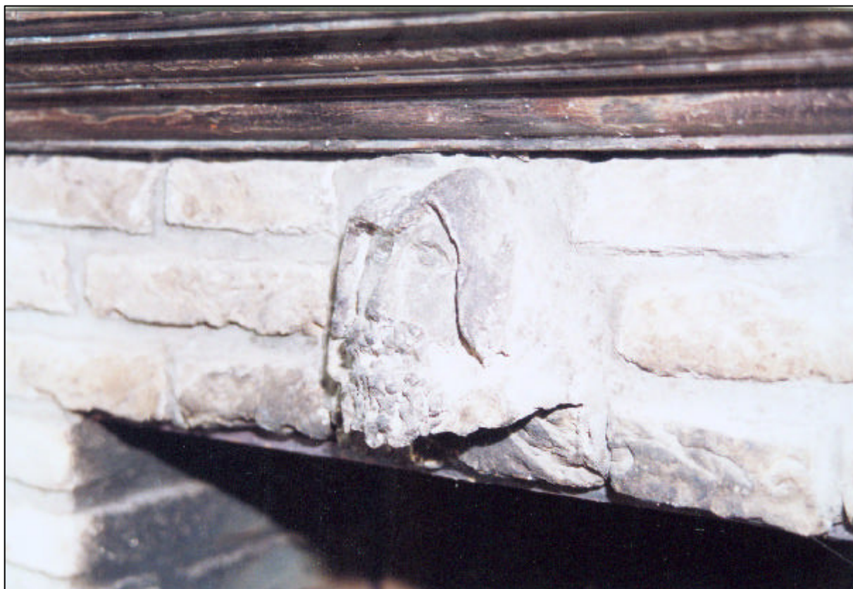
Figuur 14. Zandstenen mannenkopje ingemetseld in de schouw van de duiventil.
