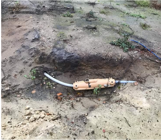
Afbeelding 8. Op en in de grond nog aanwezige bedrading.
