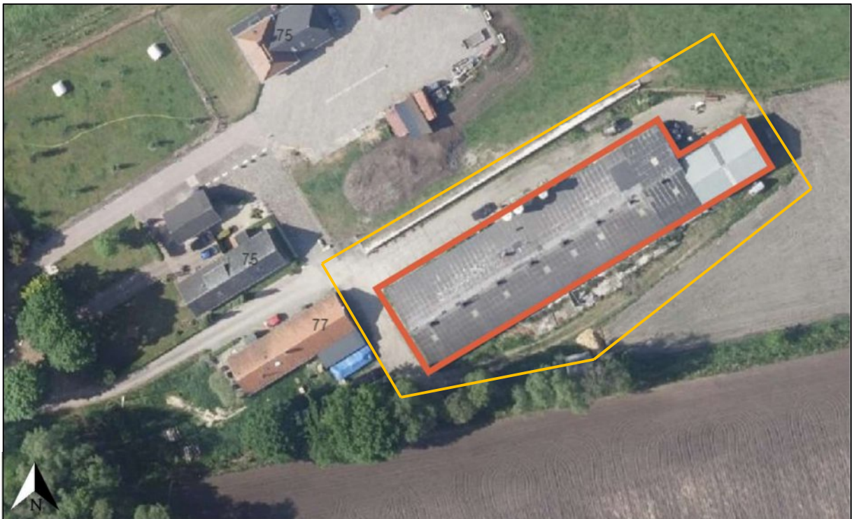
Afbakening onderzoekslocatie (in geel) en te slopen schuren in oranje.
