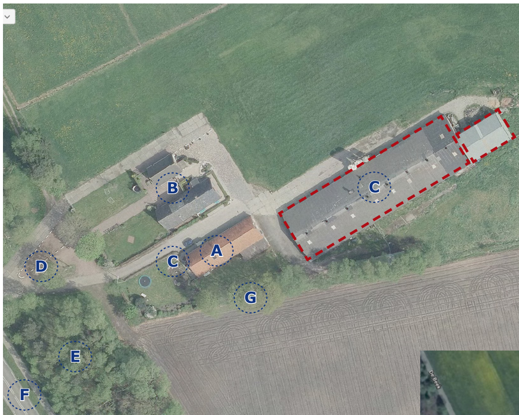
Luchtfoto 2015, een groot deel van de schuren zijn al gesaneerd.
