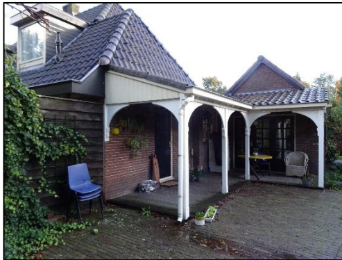
Aanzicht achterzijde woonhuis;
