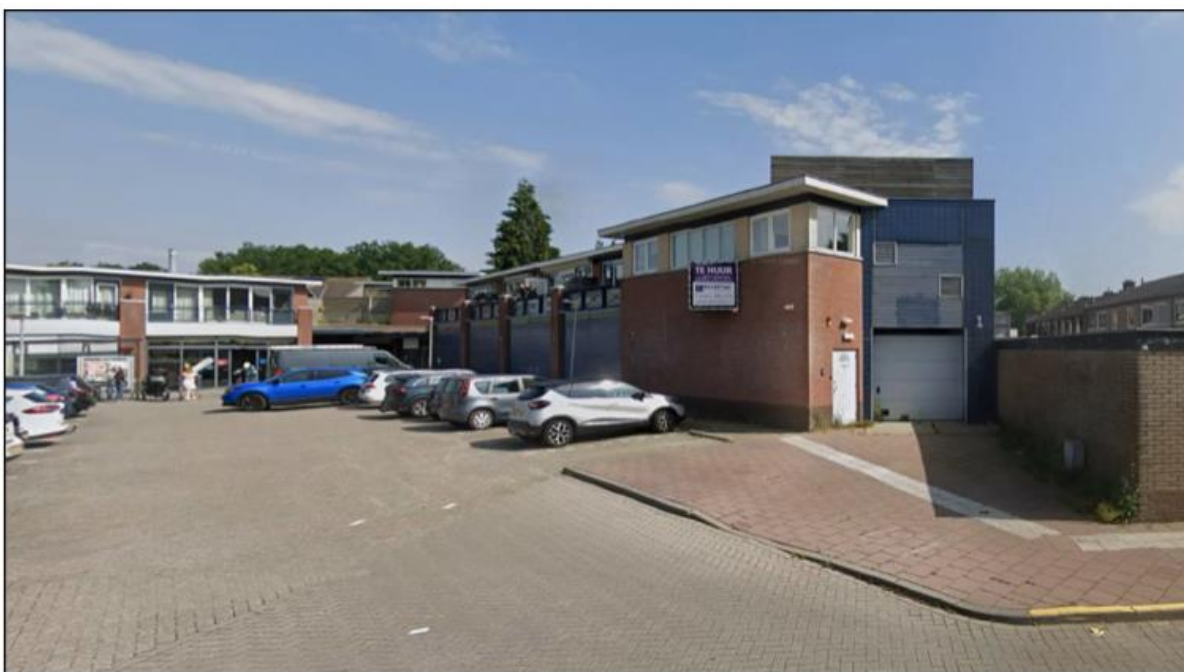
Afbeelding 2.3 Huidige situatie zijde Garsteland (Bron: Google streetview juni 2024)
