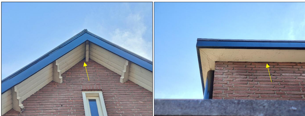
Kieren tussen de buitengevels en het dakoverstek bieden vleermuizen toegang tot holle ruimtes achter de betimmering of in de spouwmuur.
