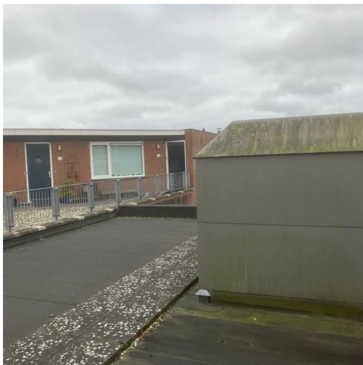
Zicht op appartementen Garsteland 24-26
