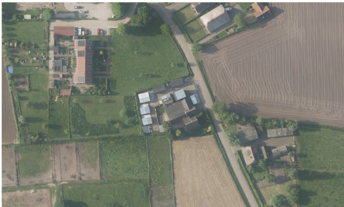
Luchtfoto van de locatie
