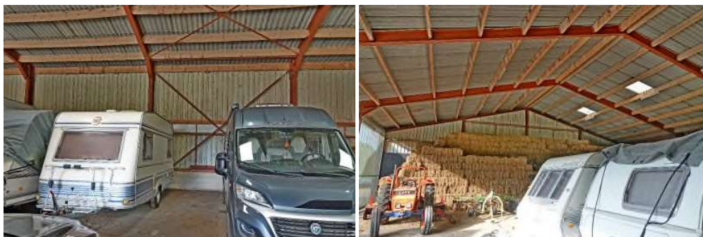
Te behouden loods / schuur – tbv loonwerk en stalling
