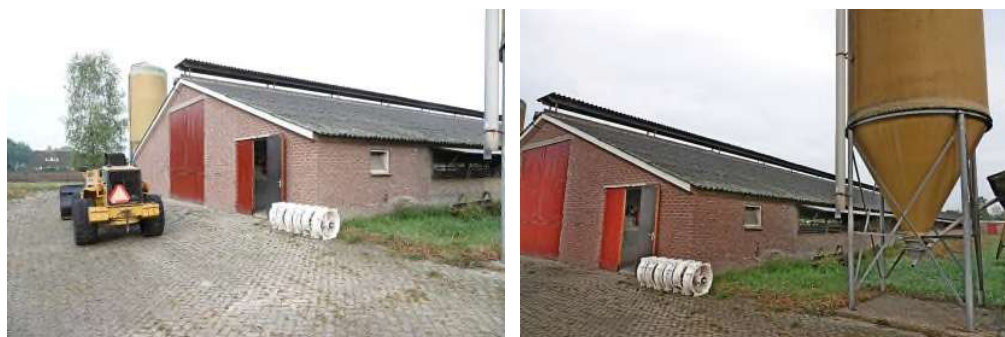
Kalkoenstal, voedersilo en shovel
