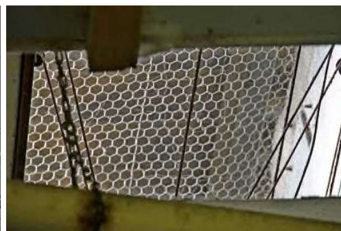
Toegang via dak afgesloten met fijnmazig gaas
