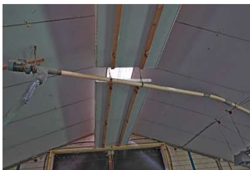
Toegang via dak afgesloten met fijnmazig gaas
