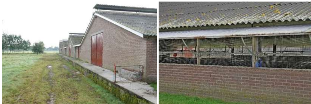
Noordwestzijde stallen (links) en natuurlijke ventilatie met gaas
