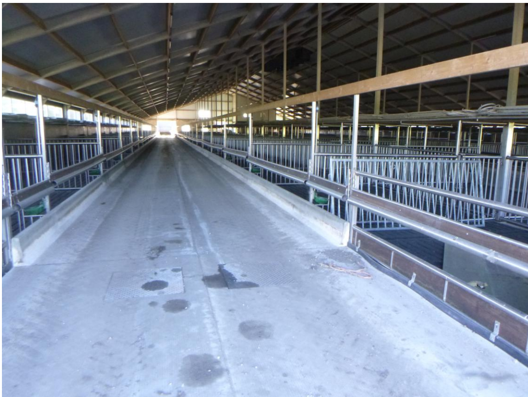
Figuur 17: Twee van de stallen met mestkelders
