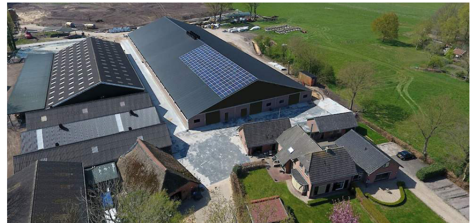
Overzicht van het perceel met op de achtergrond de te slopen agrarische loodsen
