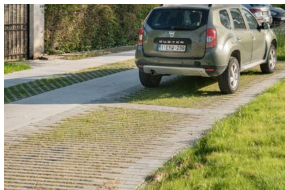
Parkeren op grasbetontegels is goed voor de waterhuishouding, en voor de integratie van verharding in de natuur.
