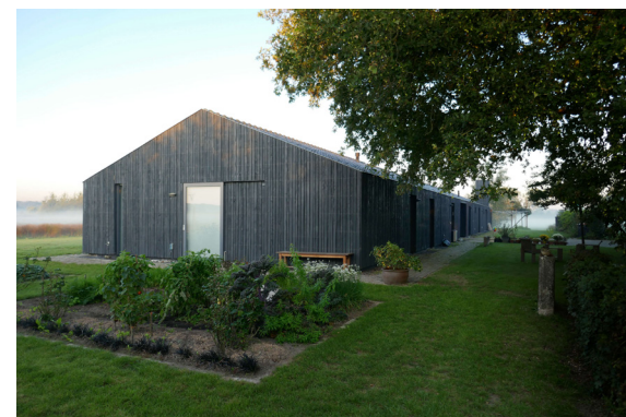
Eenvoudige hoofdvorm, maar met ambachtelijke geveldetails, zoals houten luiken of siermetselwerk.
