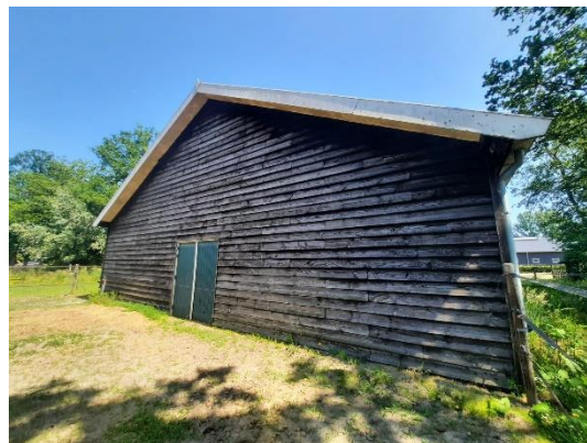
Figuur 5.2: aansluitende betimmering
