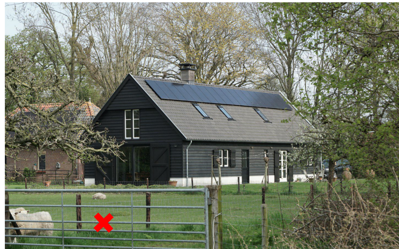
Ingetogen gevel en kopgevel
