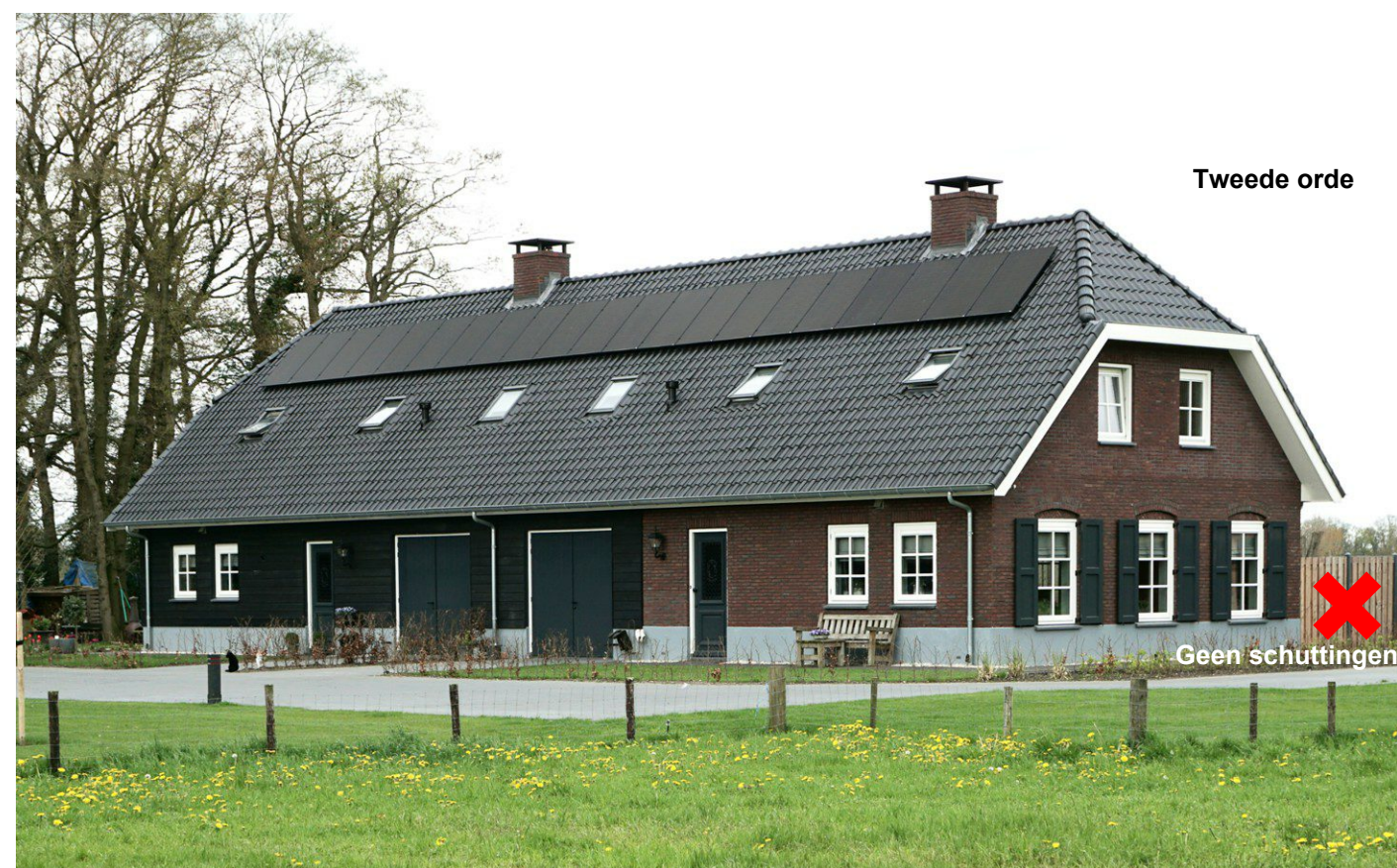
Gevel georiënteerd naar het hofje en kopgevel (metselwerk)
