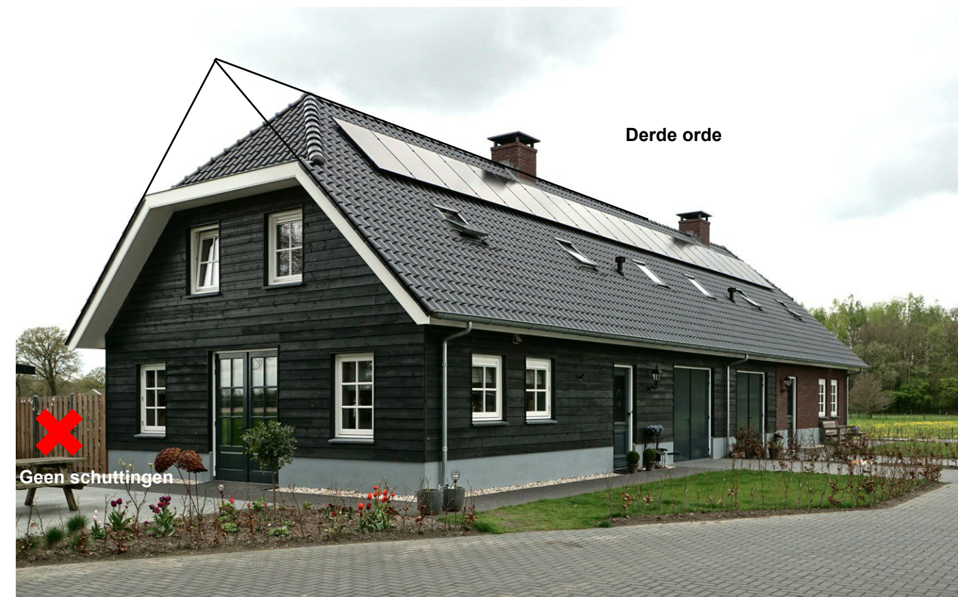
Gevel georiënteerd naar het hofje en kopgevel (houten delen)
