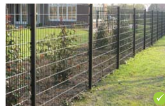
Hekwerk met draadmatten
