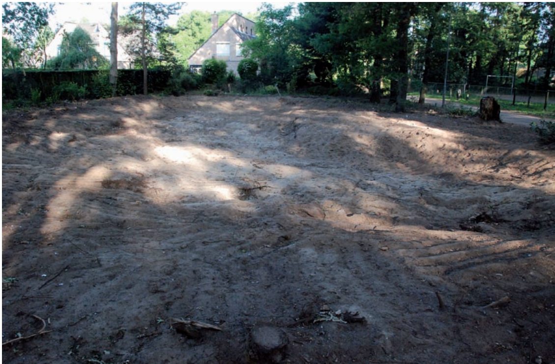
Figuur 4. Het onderzoeksgebied voor aanvang van het proefsleuvenonderzoek. Ter hoogte van het voormalige verenigingsgebouw is de grond afgegraven.
