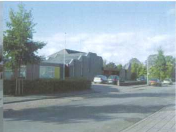
Kerkgebouw Gereformeerde Gemeente, noordoostzijde
