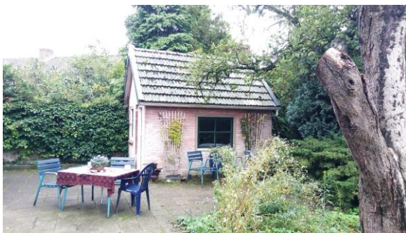
Foto 4: Het schuurtje met pannen bij het woonhuis.
