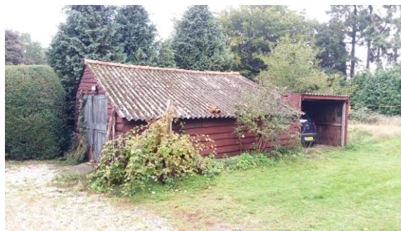
Foto 5: Schuur aan de westzijde met rechts een carport. De schuur watert aan beide zijden af en de carport alleen aan de achter- (/west)zijde, zonder dakgoot.
