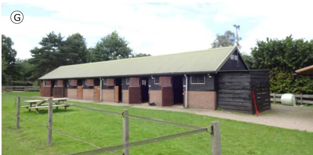
De bestaande paardenstal.
