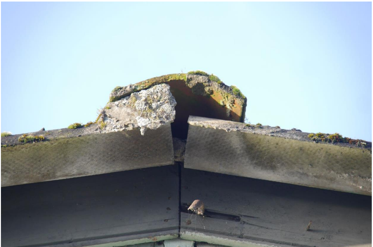
Foto 17: Nokpan niet afgedicht, mogelijk rust- of verblijfplaats van mogelijk de steenuil (opening dichtmaken!). (foto Botani-Specialist)
