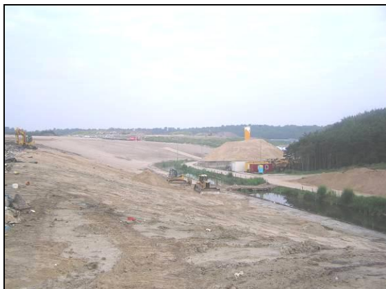
Foto 1: Uitzicht op installaties en opvangbassin. De afdeklaag is hier recentelijk aangelegd.
