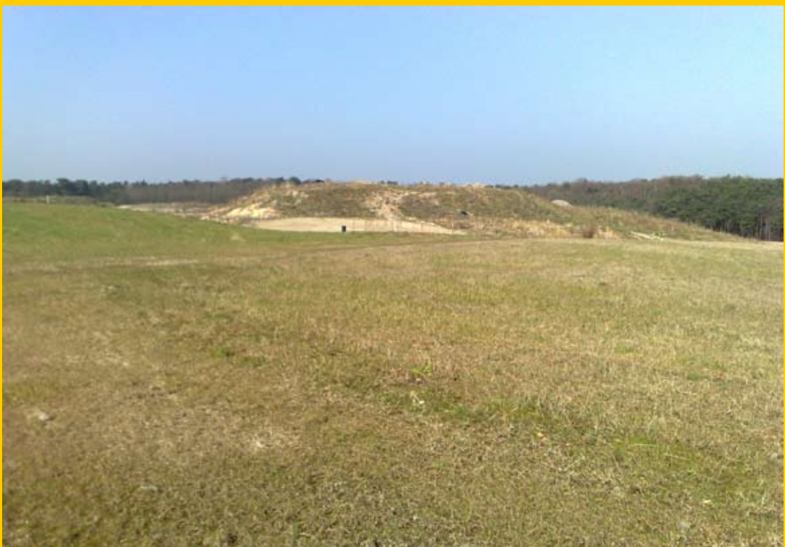
Foto 2.5: Huidige situatie vuilstort Ullerberg: het terrein is ingezaaid met erosiebestrijdende grassen zoals kweek. Het deel achter op de foto is inmiddels ook afgewerkt.
