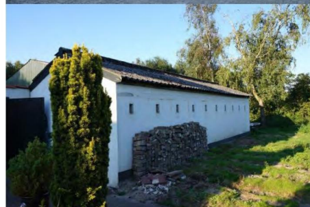
Te slopen schuren
