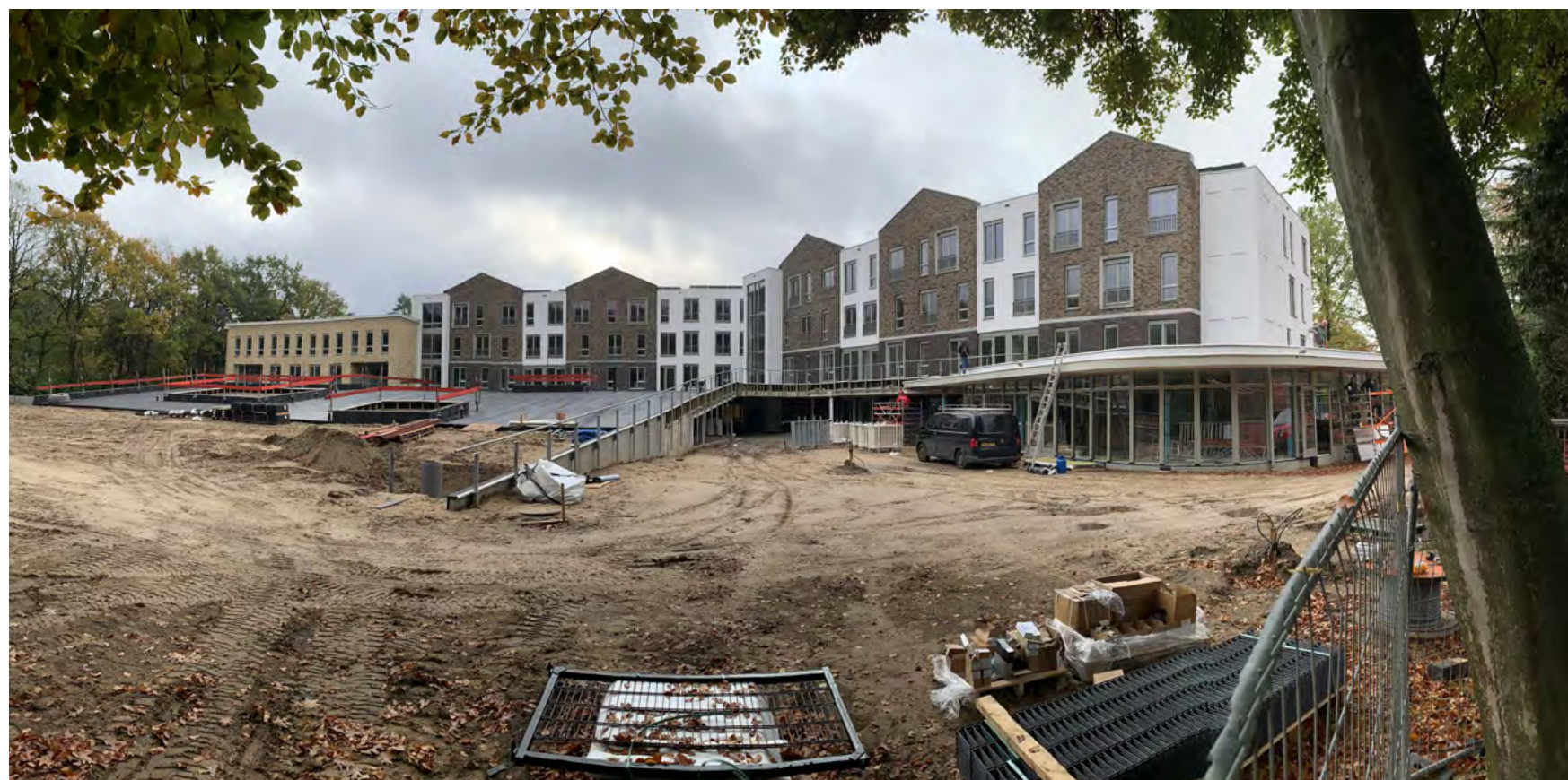
Woonzorggebouw in aanbouw, gezien vanaf het toekomstige Oranjepark
