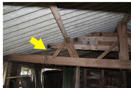
Figuur 11. Locatie verblijfplaats Kerkuil in de kippenschuur.
