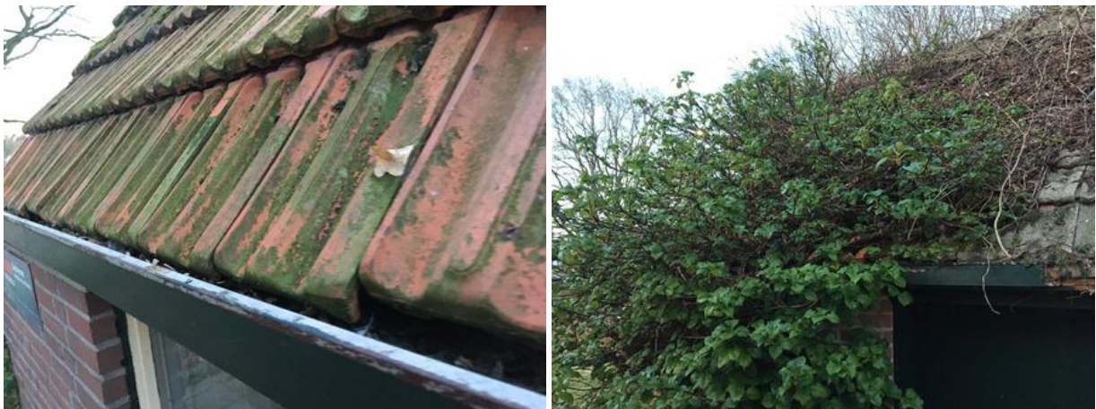
Foto links: detailopname van de dakgoot. Huismussen kunnen niet onder de dakpannen kruipen om te nestelen. Foto rechts: klimop aan bakstenen bijgebouwtje. De klimop vormt een potentiële nestplaats voor verschillende vogelsoorten.
