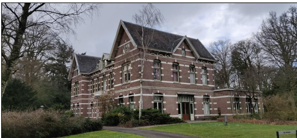
De Wissel, gezien vanuit het zuidoosten
