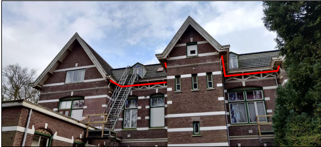
Rand tussen gevel en dakgootbekisting in de twee nissen aan de noordzijde van het gebouw met kraamverblijfplaats gewone dwergvleermuis.
