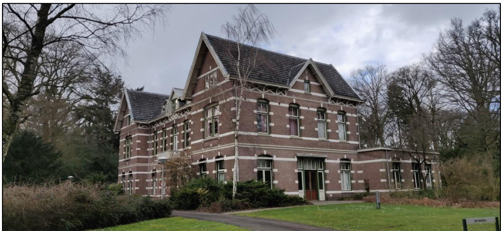
De Wissel, gezien vanuit het zuidoosten
