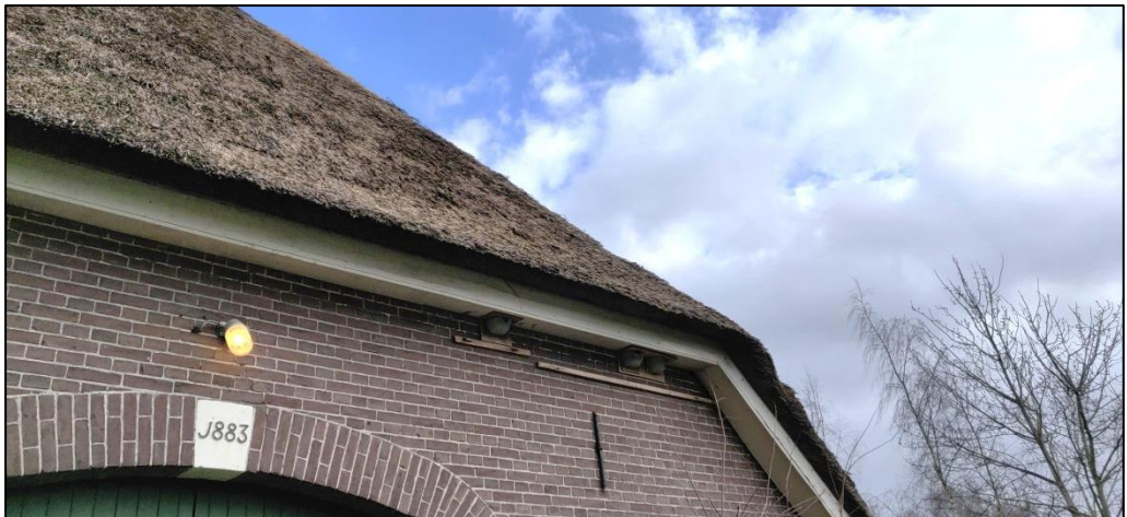
De 10 kunstnesten van de huiszwaluw aan de westgevel van De Heuvel
