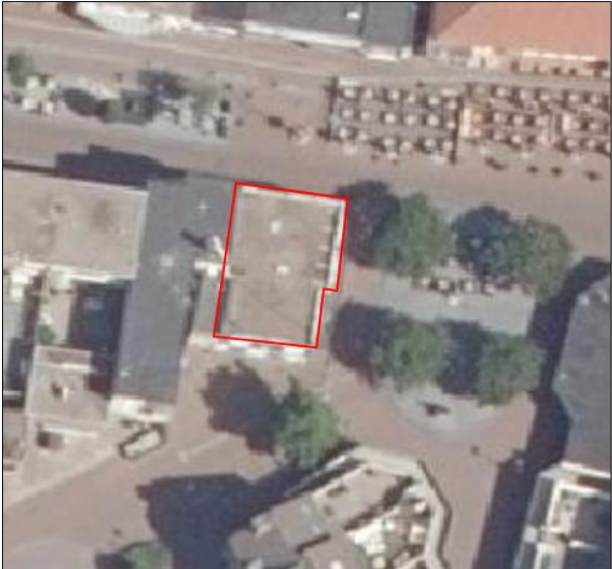
Luchtfoto van het projectgebied aan de Stationsstraat 95 (rood kader).
