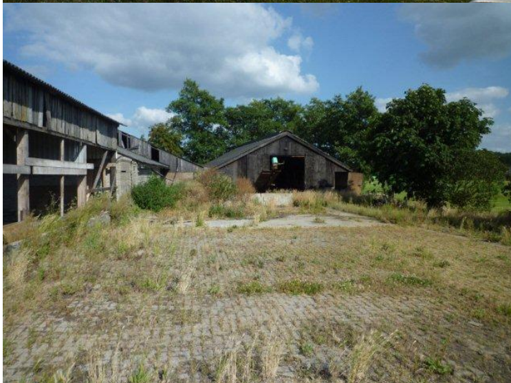
Aanzicht te slopen rundveestal en werktuigenloods
