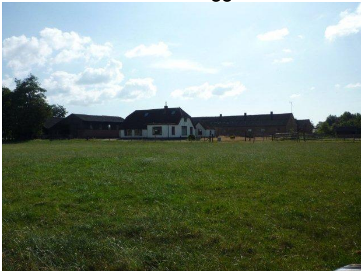
Aanzicht vanuit het omliggend weiland
