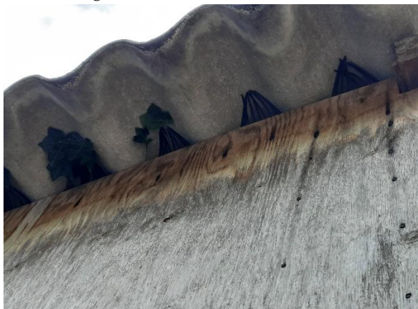
Figuur 5.2: vogelschroten toegepast
