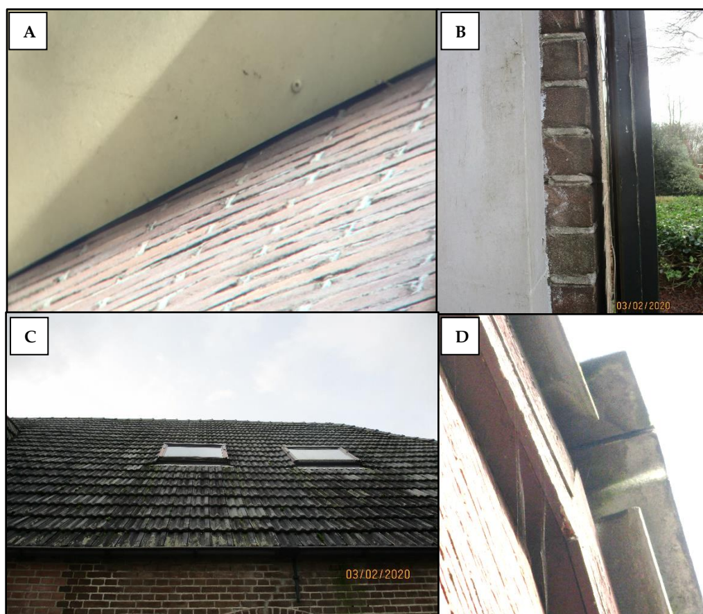
Figuur 6 A) Overstek sluit aan op gevel van bedrijfswoning; B) Er zijn geen sporen aangetroffen van vleermuizen achter de raamluiken van de bedrijfswoning; C) Dakpannen van de bedrijfswoning sluiten netjes aan; D) Daklijsten sluiten aan op de gevel van de opslag loods.
