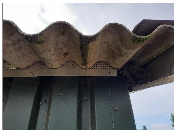
Figuur 5.1: Golfplaten zijn afgedicht.
