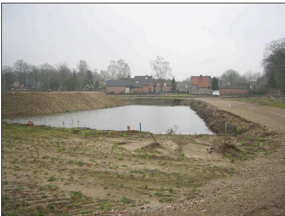
Foto 4 Tijdelijke waterpartij op het terrein van Vulcanus II (gezien in westelijke richting).
