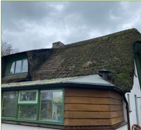
Afb. 2.3 - De rieten kap is geheel gesloten, ook via de nok. Er is geen toegang tot de ruimtes onder het dak of in het riet.
