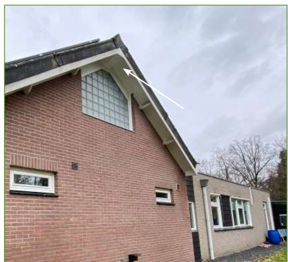
Afb. 2.11 en 2.12 - Aan de achterzijde van het praktijkgebouw is zichtbaar dat de nok invliegmogelijkheden (zie witte pijl) biedt voor vleermuis. De boeiboorden zijn hier door het gebruik "schoongeveegd".
