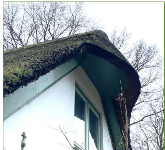
Afb. 2.1 en 2.2 - Er zijn voor huismus en gierzwaluw geen mogelijkheden om onder het rieten dak van de woning te komen. Het dak sluit nauw aan op de muren; er zijn geen openingen en toegang tot beschutte ruimtes.
