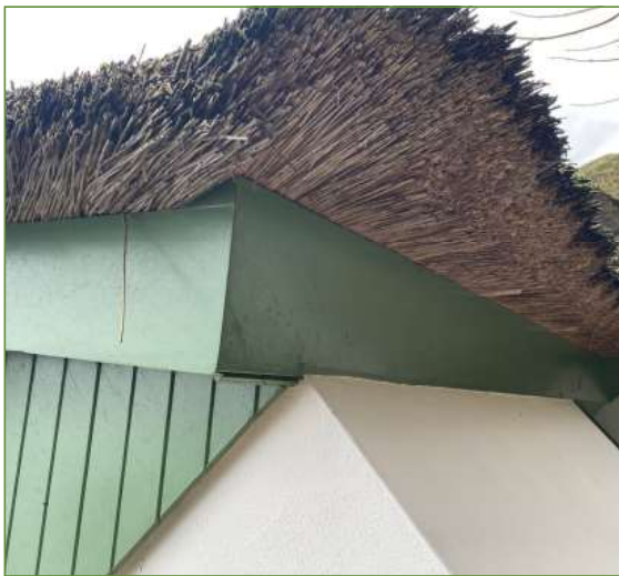
Afb. 2.7 en 2.8 - De kap van de woning sluit nauw aan op de boeiboorden en muren. Ook achterlangs de gevelbetimmering zijn geen mogelijkheden voor vleermuizen om in beschutte ruimtes van de woning te komen.
