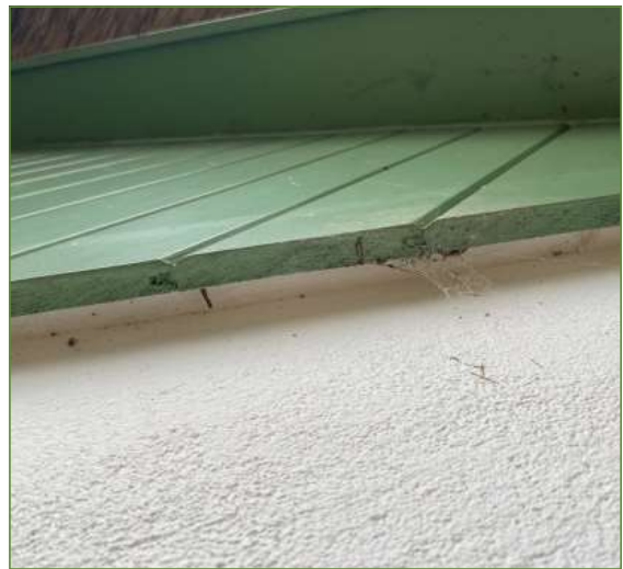
Afb. 2.7 en 2.8 - De kap van de woning sluit nauw aan op de boeiboorden en muren. Ook achterlangs de gevelbetimmering zijn geen mogelijkheden voor vleermuizen om in beschutte ruimtes van de woning te komen.
