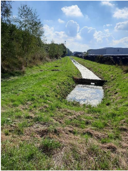
foto 1: Sloop aan westzijde locatie, gezien vanuit noorden
