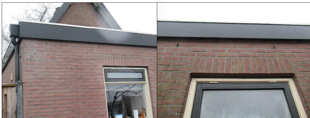
Afbeelding 6: Potentiële toegangsmogelijkheden voor vleermuizen (Aveco de Bondt, 2020).
